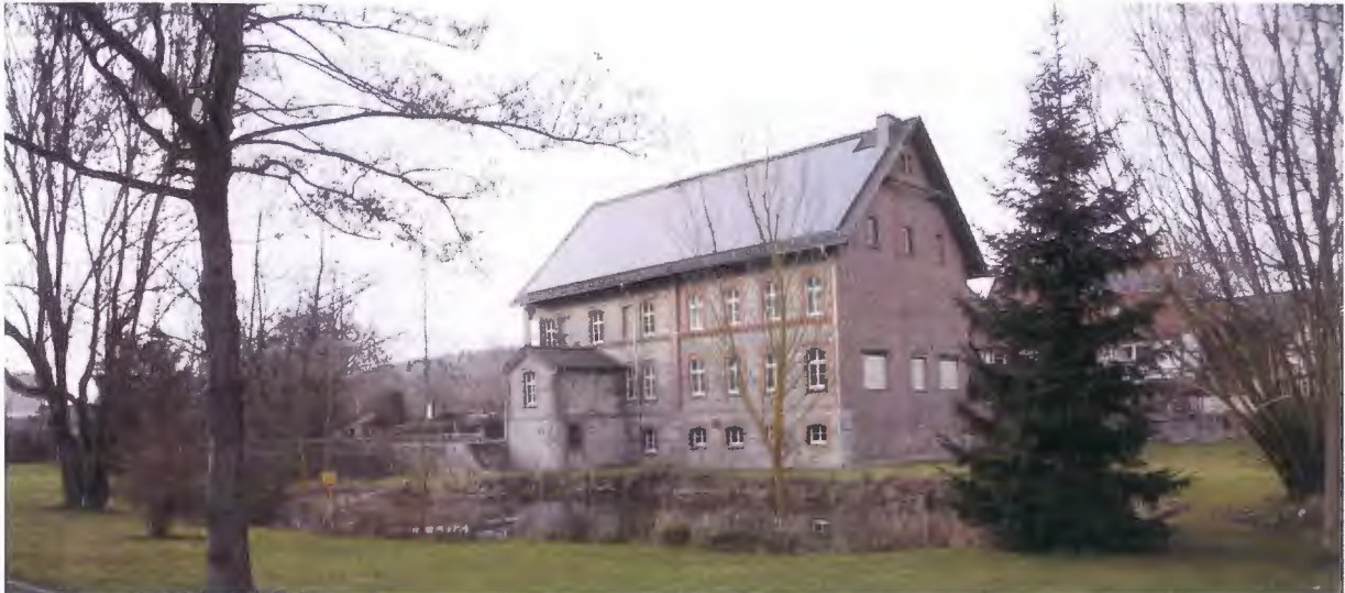
Ehemaliges Mühlengebäude, Kalksteinbau, Alter Steinweg 2 Liebenau, eigene Darstellung
